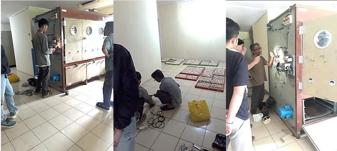
Gambar 3. Kegiatan perbaikan mesin tetas Jimmy Farm di ruang penetasan UPBS Ayam mulai dilakukan pada bulan Maret 2025.
